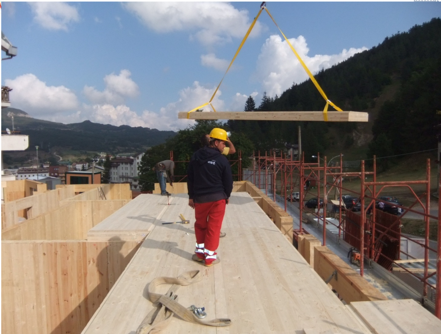
POSIZIONAMENTO DELLE LASTRE SOLAIO
